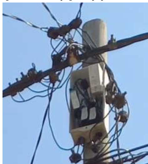
Figure 39- EDM Comptage BT à prépaiement sécurisé
