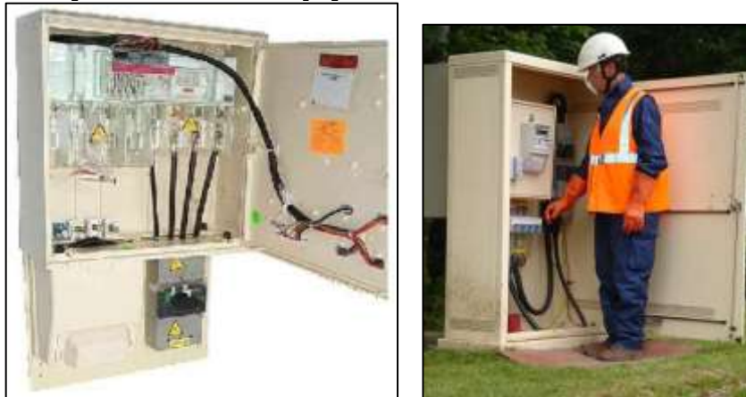
Figure 6 -ENEDIS Exemple de branchement BT > 36 kVA
