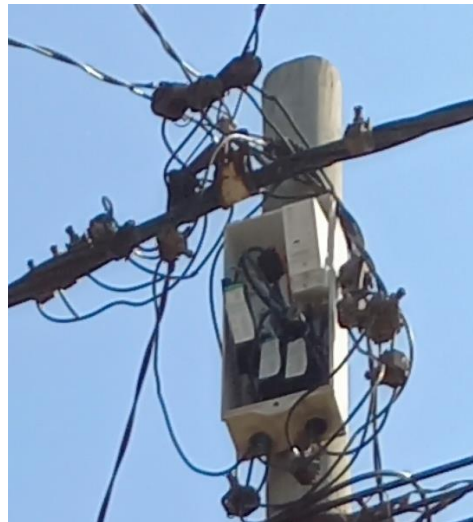
Figure 39- EDM Comptage BT à prépaiement sécurisé
