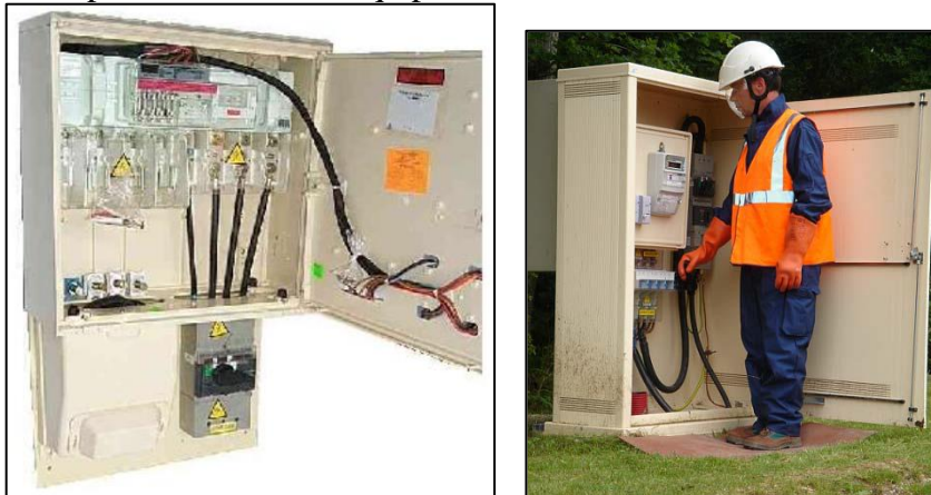
Figure 6 -ENEDIS Exemple de branchement BT > 36 kVA
