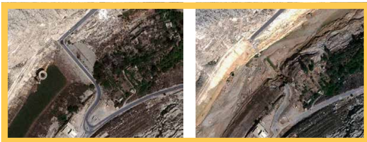
Fig. 14 Observation des dommages et destruction du barrage hydroélectrique après la tempête à Derna en Libye en 2023 (Images Pleiades Neo (résolution 30 cms))
